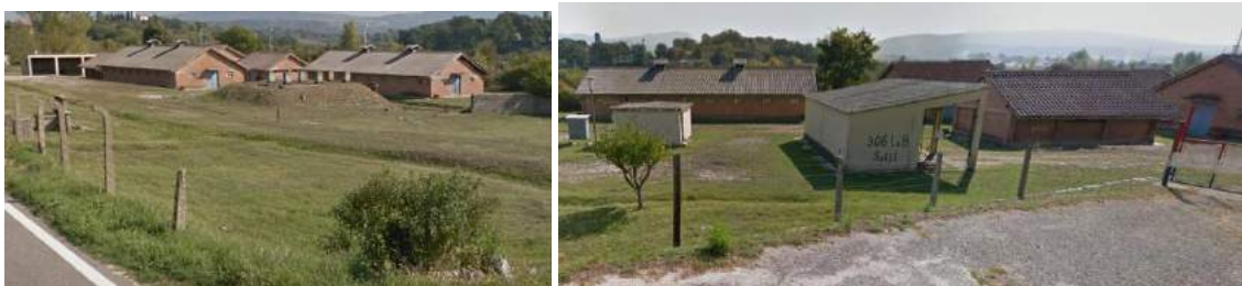
Slika 1.1 Bivša vojna skladišta na lokaciji planiranog zahvata (Izvor: www.google.hr/maps )
