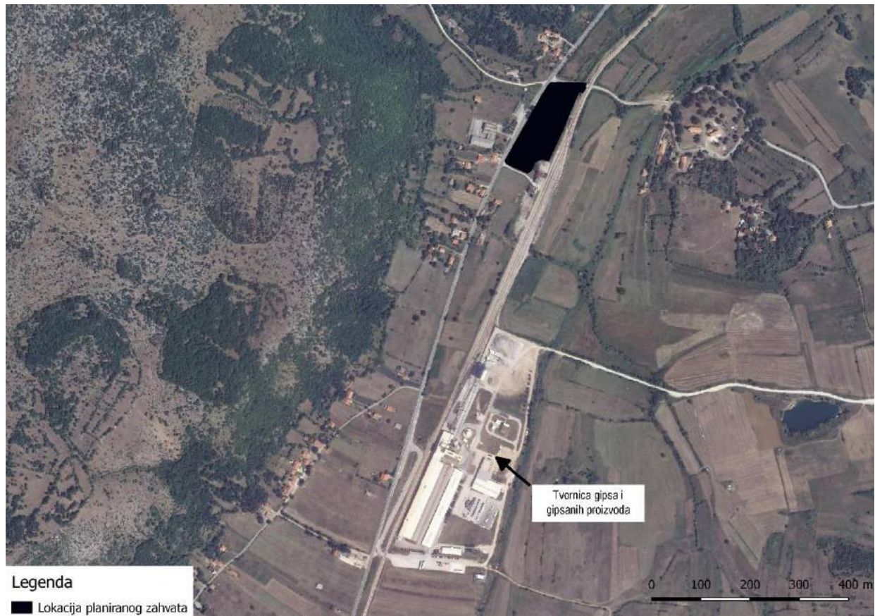
Slika 2.21 Lokacija planiranog zahvata u odnosu na postojeću tvornicu gipsa i gipsanih proizvoda Knauf (Izrađivač: IRES EKOLOGIJA d.o.o.)
